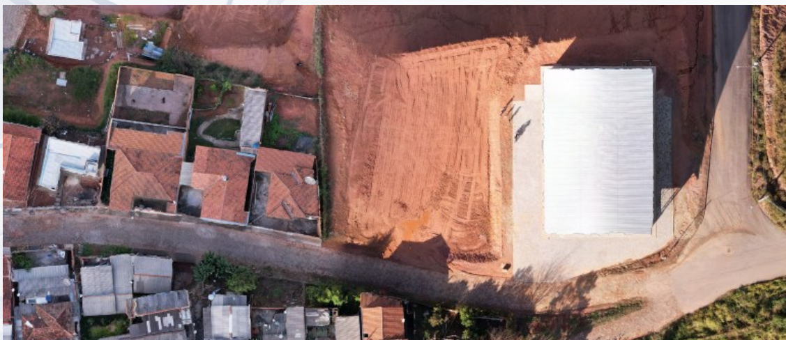
Foto 01 – Local da Instalação da UBS TIPO I em no Bairro Vila de Lourdes em Maria da Fé
